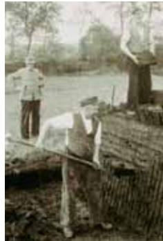
Handtorfstich im Hohen Moor in den 50er Jahren.
